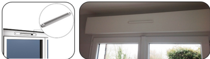
Barrettes de ventilation
