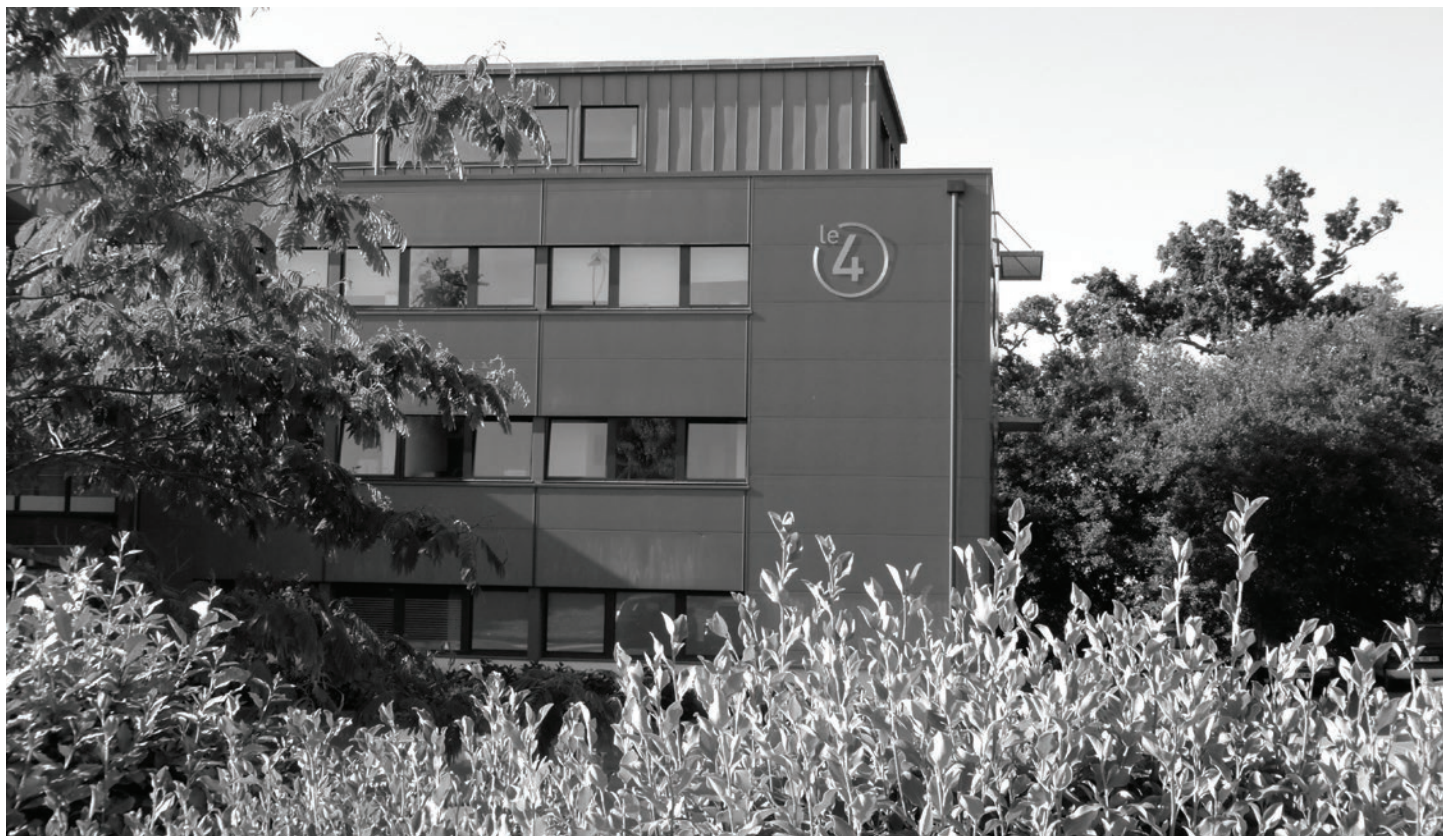
ZAE Creac'h Gwen - Quimper (Bâtiment le 4)
