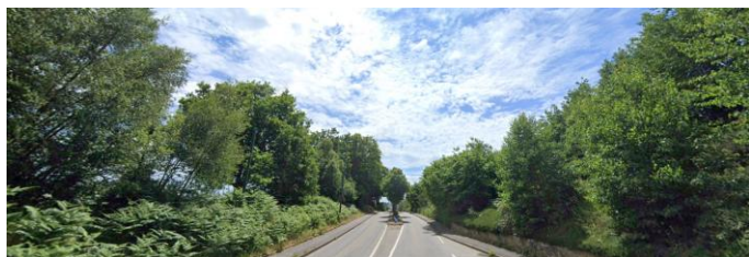
Entrée au nord-ouest via la D63 – Zone d'activité cachée par les talus végétalisés
