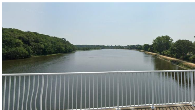
Figure 10 : Le bassin aval de Quimper - Source : Google Maps
